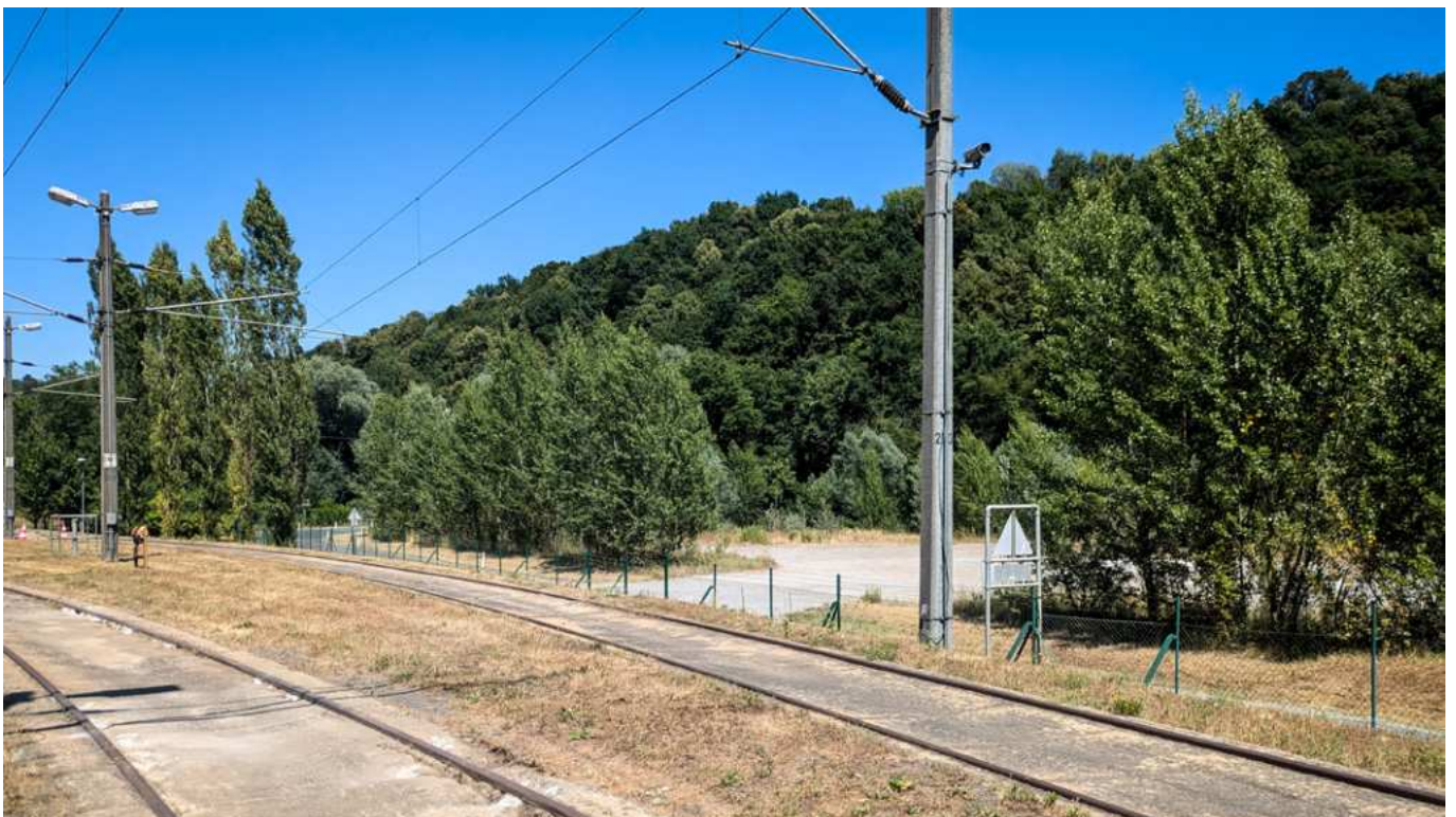
Die Anschlussbahn umfasst diverse Strecken - eine ideale Voraussetzung für Fahrzeugtestungen. Credit: PJM, honorarfrei
