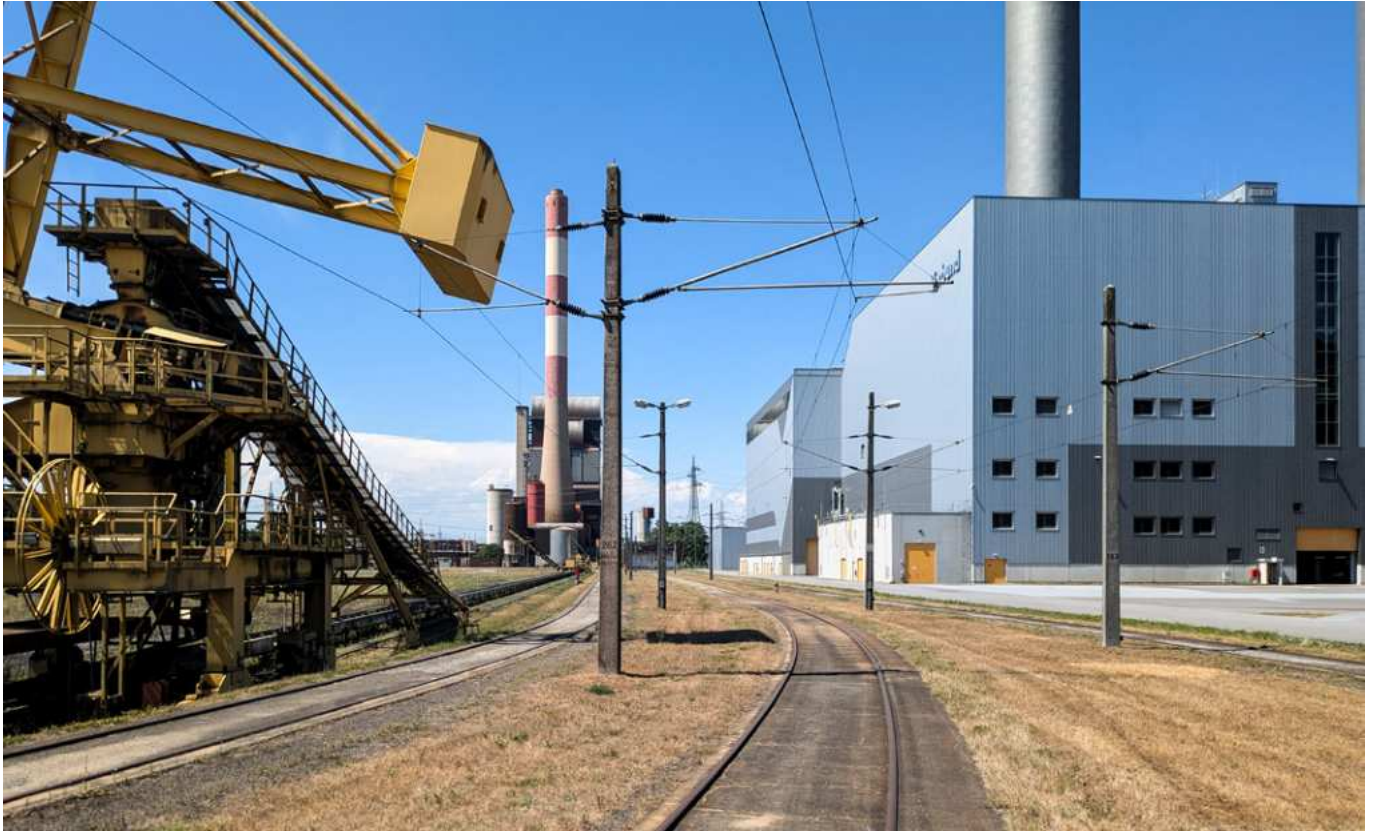
Das Gelände liegt verkehrstechnisch ideal und verfügt über eine umfangreiche Infrastruktur, wie z.B. eine große Halle inklusive Dacharbeitsstand und Kran. Credit: PJM, honorarfrei
